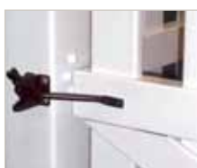
Detalle del herraje de cierre de puerta.
